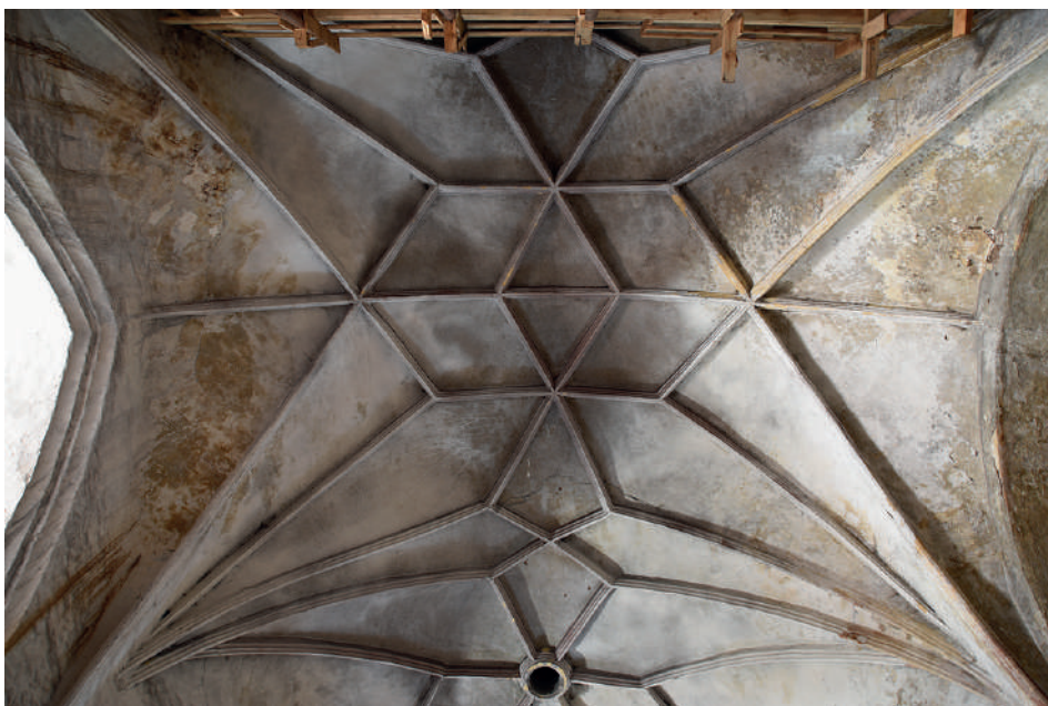
Il 2. Fragment siatki sklepienia nawy głównej. Stan z 2020 r. Foto: A. Peszko
