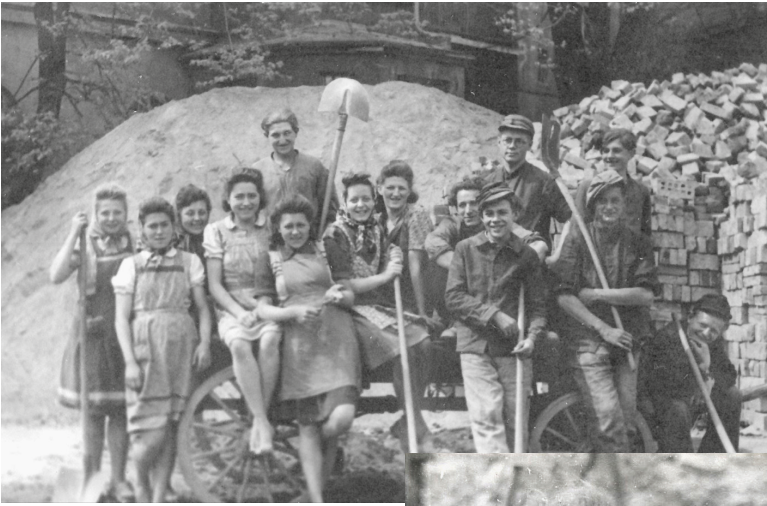
8. Młodzież z Wudwora na budowie Serbskiego Domu (Ska)
