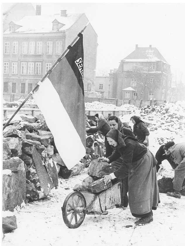
7. Członkowie Serbskeje Młodźiny na budowie Serbskiego Domu (Ska)
